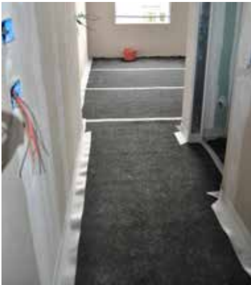
▲ Colocación del colchoncillo DAMPROLL en la obra de viviendas de la UNIVERSIDAD DE LECCO
