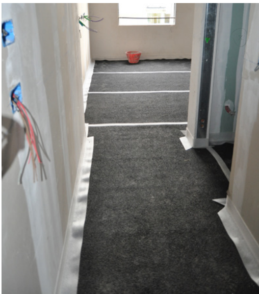
▲ Mise en place du matelas DAMPROLL sur le chantier de logements de l' UNIVERSITÉ de LECCO
