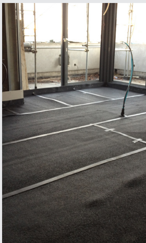
Détail des phases de mise en place du matelas DAMPROLL FORÊT VERTICALE (MILAN)
